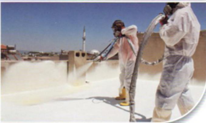
Terasınız kaç metre olursa olsun, hiç bir rıç kaybı ve köprüsü oluşturmadan alttan ve üstten tek parça olarak uygulanabilmesi yüksek kalite ve maksimum tasarruf sağlar.
