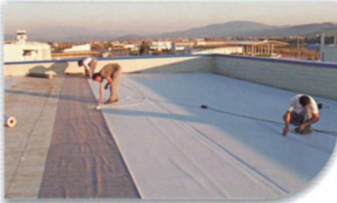
Su yalıtımı sistemi, alt yüzey üzerine direkt uygulanmış geotekstil keçe katmanı ve tek kat su yalıtım membranından oluşmaktadır. Su yalıtımı 2 .kat geotekstil ve polietilen film ile tamamlanmıştır.
